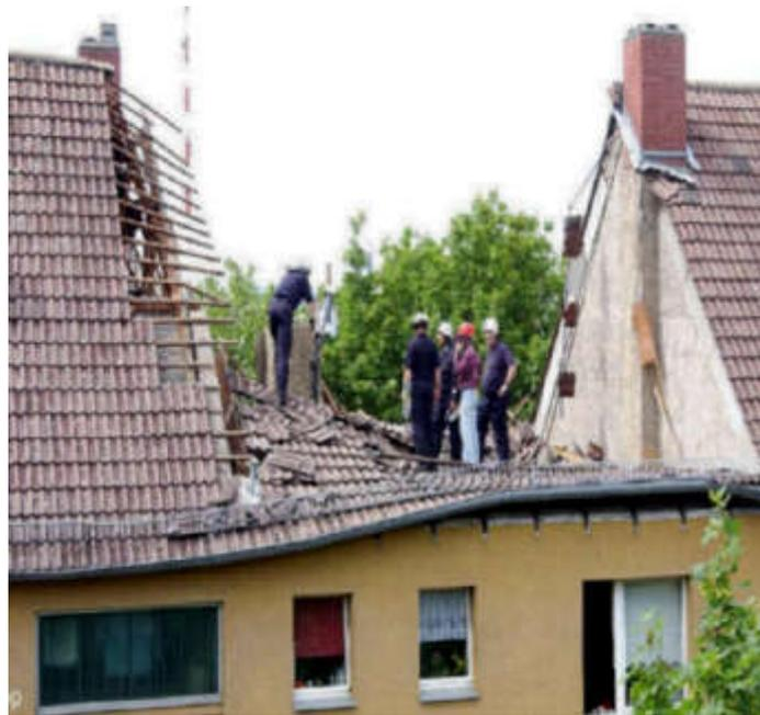
Bild 1: Eingestürztes Dach
