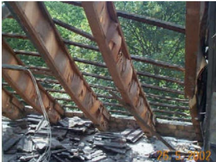
Bild 2: Schadhafte Wellstegträger als Dachsparren
