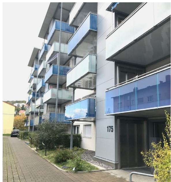
48 Der Anbau einer kombinierten Balkon-Aufzugs-Anlage ermöglicht den barrierefreien Zugang zu Balkonen und Wohnungen in allen Stockwerken; Römerstraße, Leonberg
