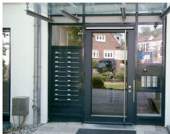
28 Vertikale Griffstange und niedrig gesetzte Klingelanlage; Elbschloss Residenz, Hamburg
