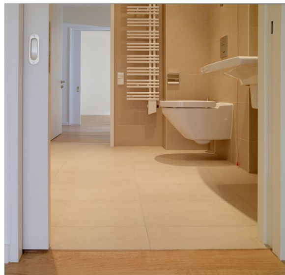
57 Ein schwellenloser Übergang vom Flur ins Bad sollte auch bei geringen Fußbodenaufbauten realisiert werden; Elbschloss Residenz, Hamburg
