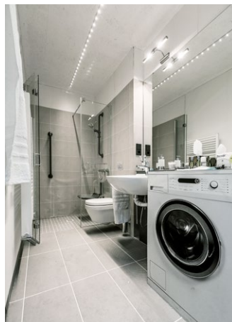
71 Schwellenloser Übergang zum Bad mit Schiebetür; Elbschloss Residenz, Hamburg
