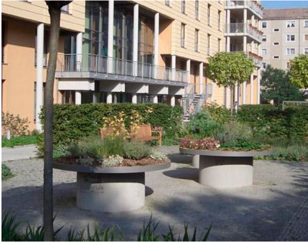
23 Das unterfahrbare Hochbeet besteht aus einem handelsüblichen Betonschachtring mit einer darauf liegenden Stahlplatte. Eine 12 cm hohe Aufkantung hält die Pflanzenerde.
