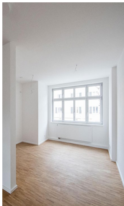
58–59 Nach der denkmalgerechten Sanierung sind die Fensterflügel auch aus sitzender Position (max. Höhe 120 cm) bedienbar; Hohenzollernhöfe, Ludwigshafen
