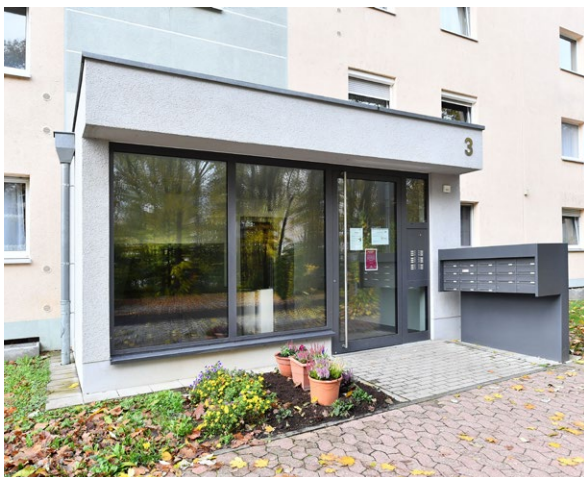
30 Barrierefreier Zugang mit unterfahrbaren Briefkastenanlage, Brahmsweg, Mainz
