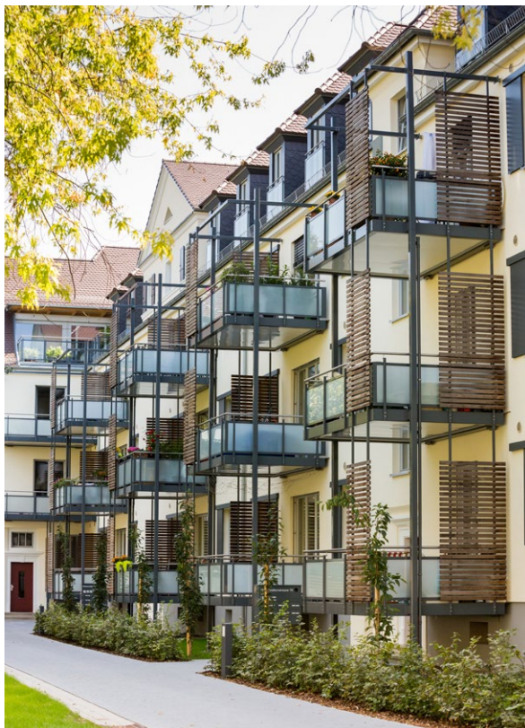
61 Vorgestellte Balkone mit Aufzugsanlage an einem denkmalgeschützten Gebäude; Hohenzollernhöfe, Ludwigshafen
